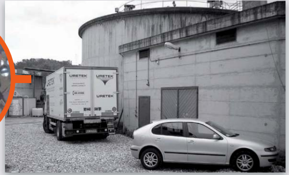
Digestore dell'impianto di depurazione di La Spezia.
