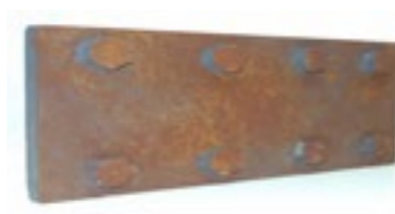
Effetto ruggine Rust effect
