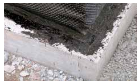
Impermeabilizzazione della guscia di raccordo fra platea e muro d'elevazione
