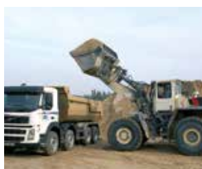
Escavatori e bulldozer
