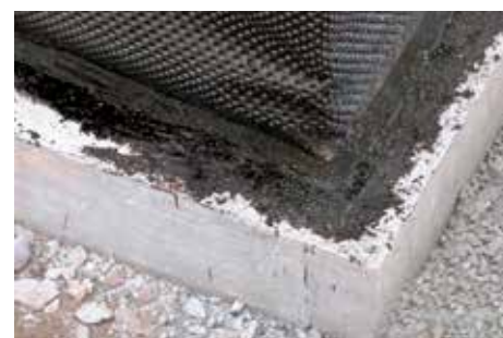
Membrana bugnata come protezione della fondamenta.
