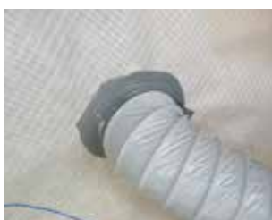
Sigillatura di tubi per cappe.
