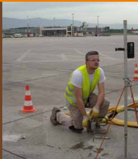
Controllo del ricevitore laser durante l'iniezione.
