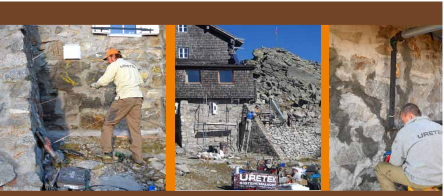
Posa dei tubi d'iniezione per il Walls Restoring®.
