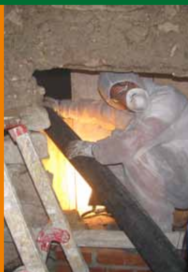
Tubi d'iniezione attraversano la fondazione continua.
