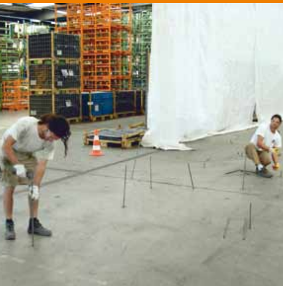
Foratura e posizionamento dei tubi per l'iniezione della resina.
