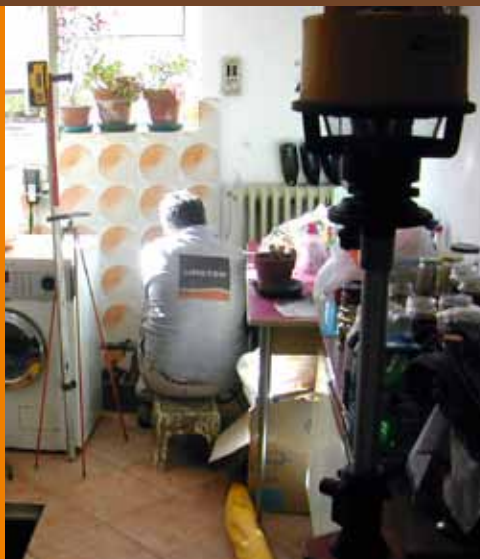
Monitoraggio laser durante l'iniezione
