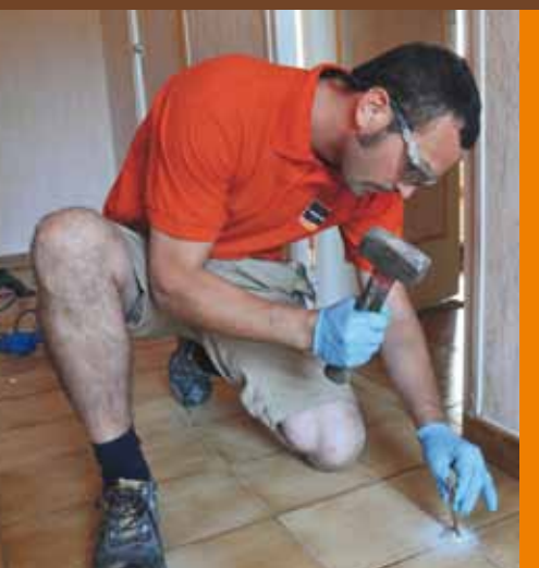
3 Inserimento dei tubi d'iniezione
