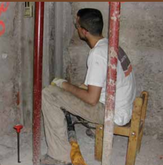
Controllando il laser durante l'iniezione della resina Geoplus®.
