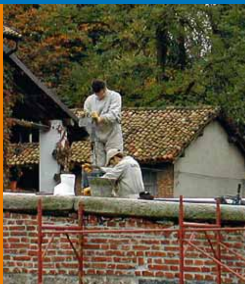
Foratura del piano carrabile.
