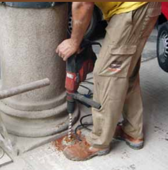
Fase di foratura del plinto di fondazione di una colonna.
