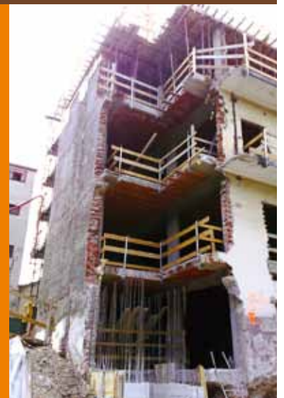
Il vecchio edificio prima della demolizione.
