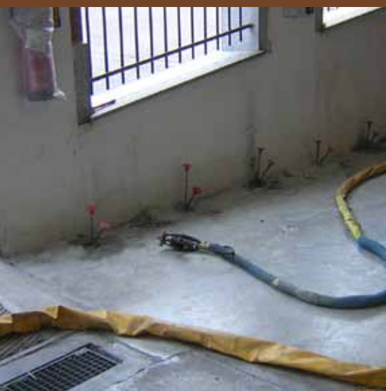
Iniezione di resina URETEK Geoplus® particolare dell'intervento.
