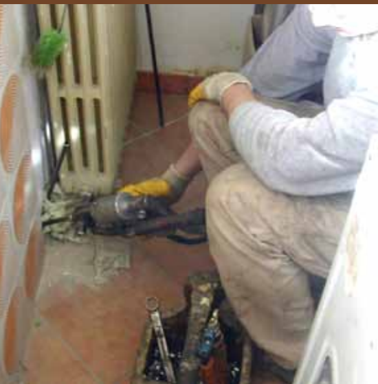
Particolare della pistola d'iniezione
