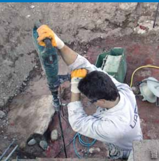
Particolare della fase di foratura in verticale.
