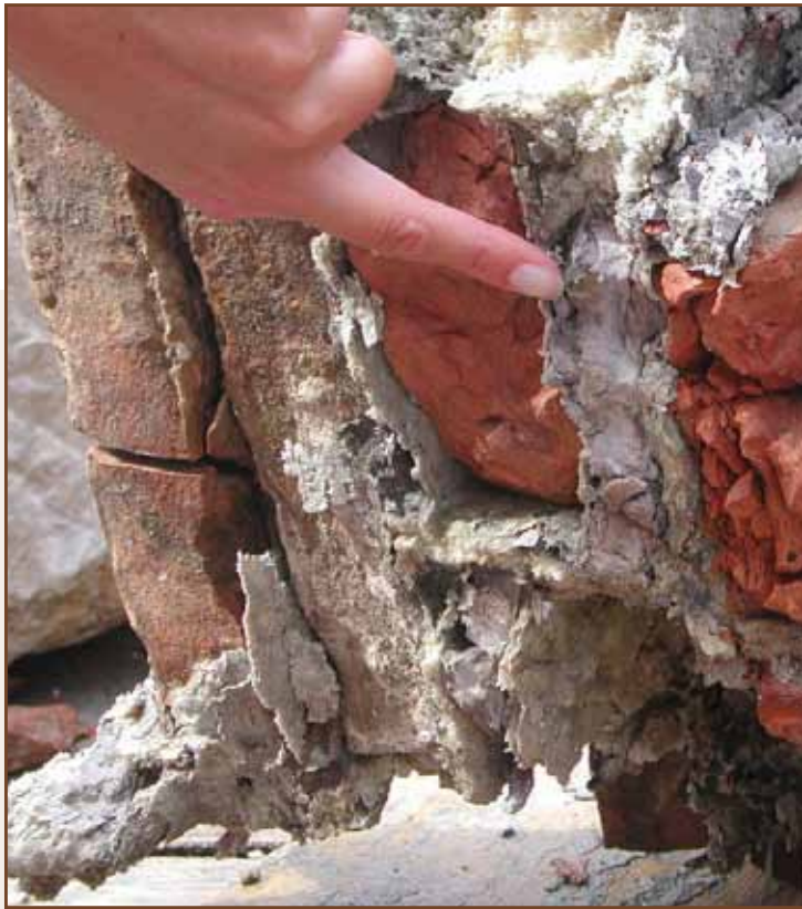
Vista del riempimento dei vuoti in seno alla muratura.
