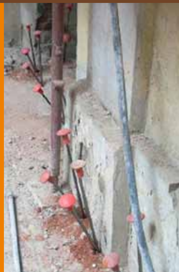
Tubi inseriti e pronti per l'iniezione.
