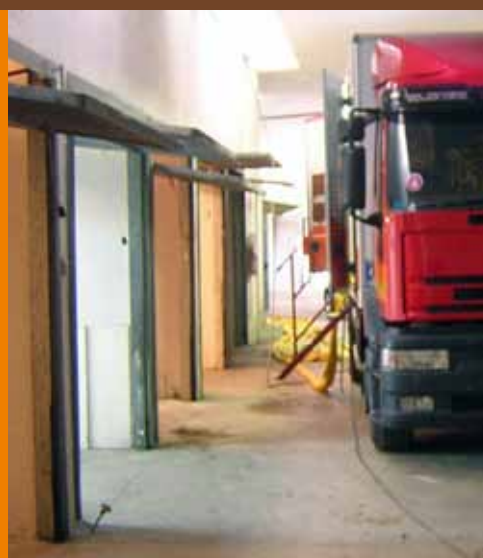
Fase d'iniezione della resina al piano autorimesse.
