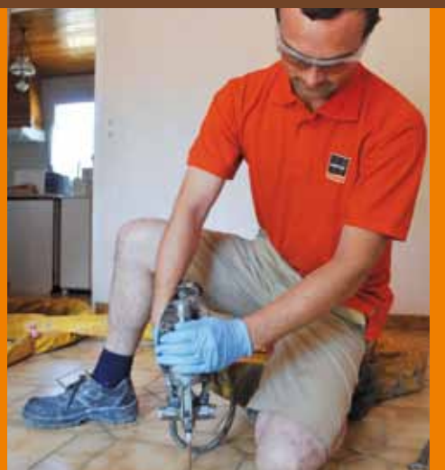
4 Iniezione della resina espandente
