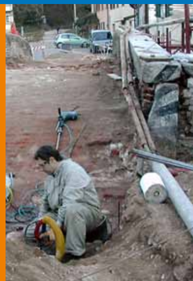
Iniezione della speciale resina IDRO CP 200®.
