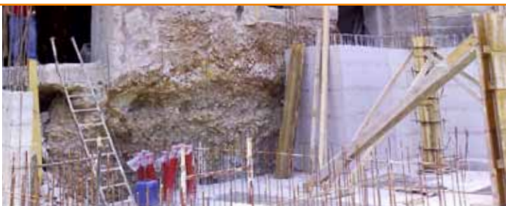
Fronte di scavo con inizio della nuova costruzione.
