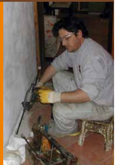
Iniezione della resina Geoplus®
