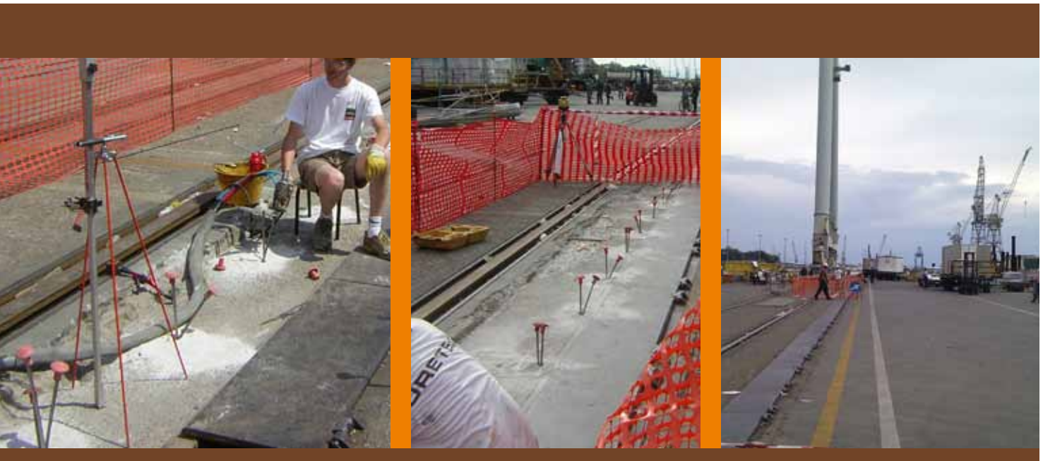
Fase d'iniezione della resina URETEK Geoplus®.
