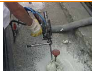
Particolare della pistola d'iniezione della resina..
