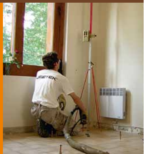
5 Monitoraggio laser dei sollevamenti
