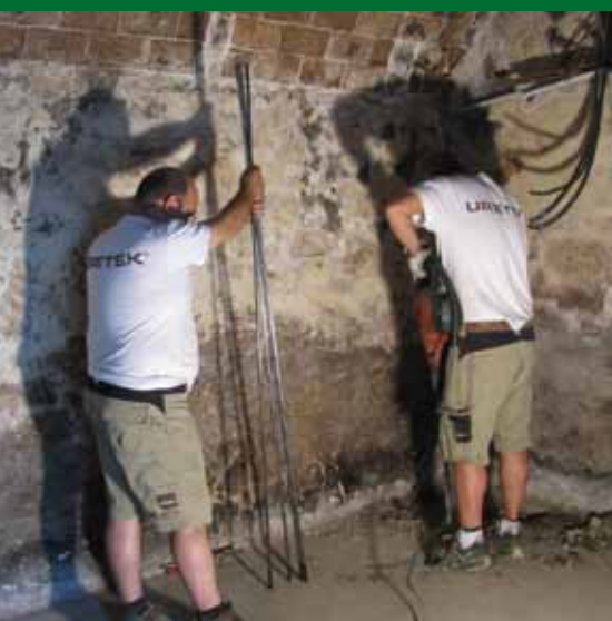
Estrazione del tubo durante l'iniezione: metodo "colonnare".
