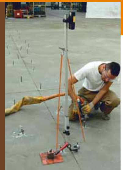
Iniezione della resina.
