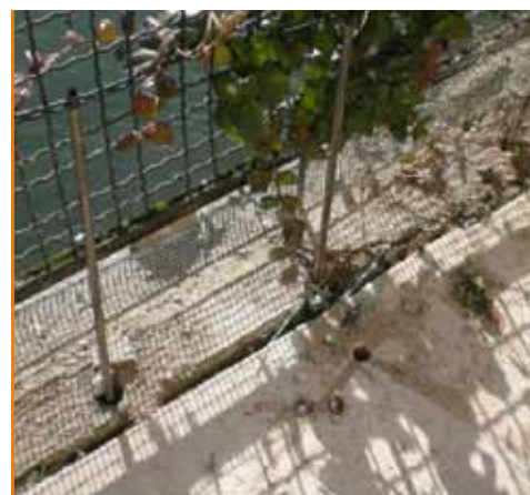
particolare dei tubi per l'iniezione della resina
